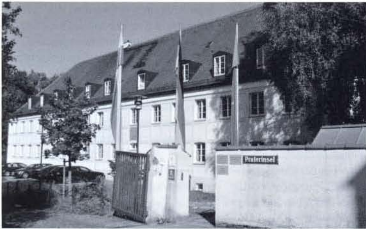
Das Gebäude der Landeszentrale liegt bereits in Sichtweite des Bayerischen Landtags.
